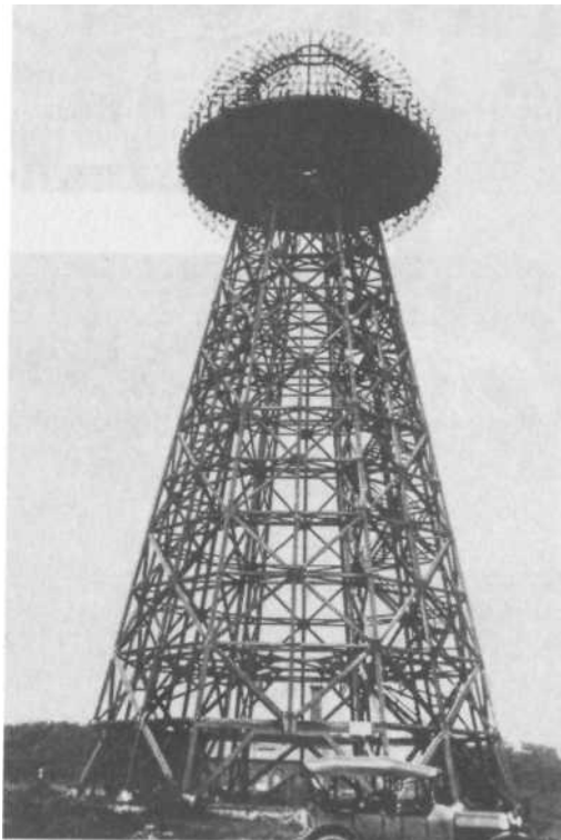
Abb. 91: Der Wardenclyffe-Turm, mit dem Tesla beabsichtigte Energie über den Atlantik zu übertragen
